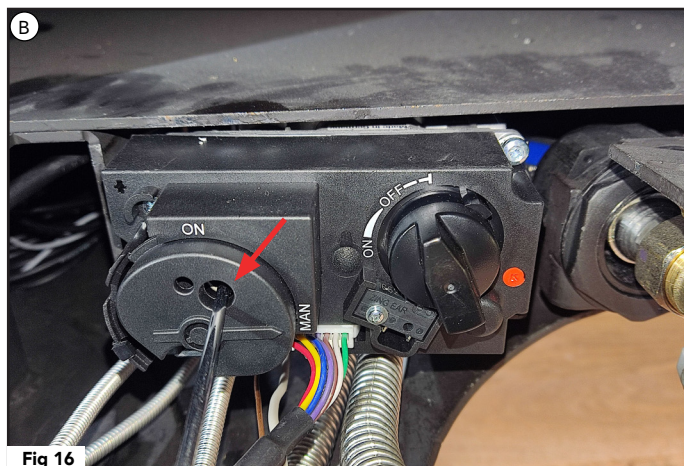
Fig 16 Maintenez la valve enfoncée.
